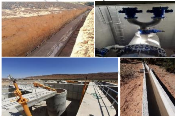
أشغال تهيئة التجهيزات الهيدرولوجية علمستوى سافلة سد قدوسة
